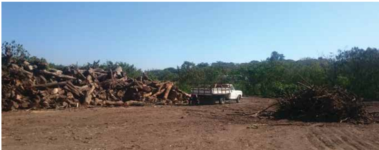
Foto 25. Acumulação de troncos e pilha para maturação de folhas e galharias
