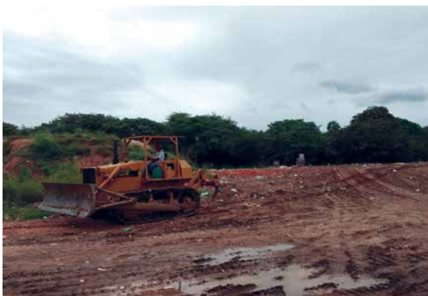
Foto 3. Área do aterro de São Gonçalo do Amarante
