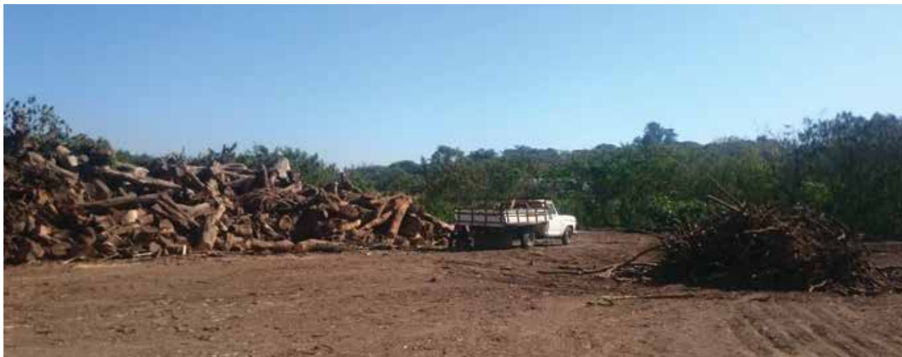
Foto 22. Acumulação de troncos e pilha para maturação de folhas e galharias
