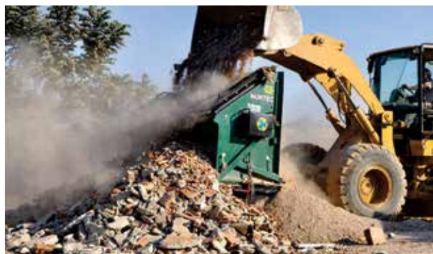
Foto 13 . Operação com a Peneira Vibratória
